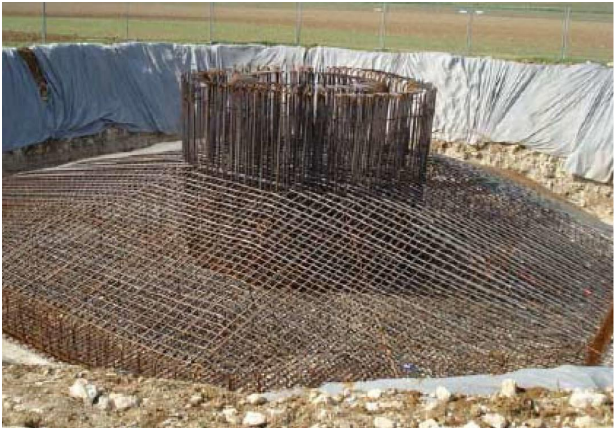
FIGURE 7 : PHOTO DU FERRAILLAGE D'UNE FONDATION TYPE
