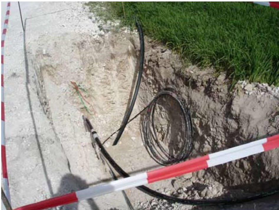
FIGURE 25 : PHOTO D'UNE TRANCHEE POUR L'ENFOUISSEMENT DES CABLES ELECTRIQUES
