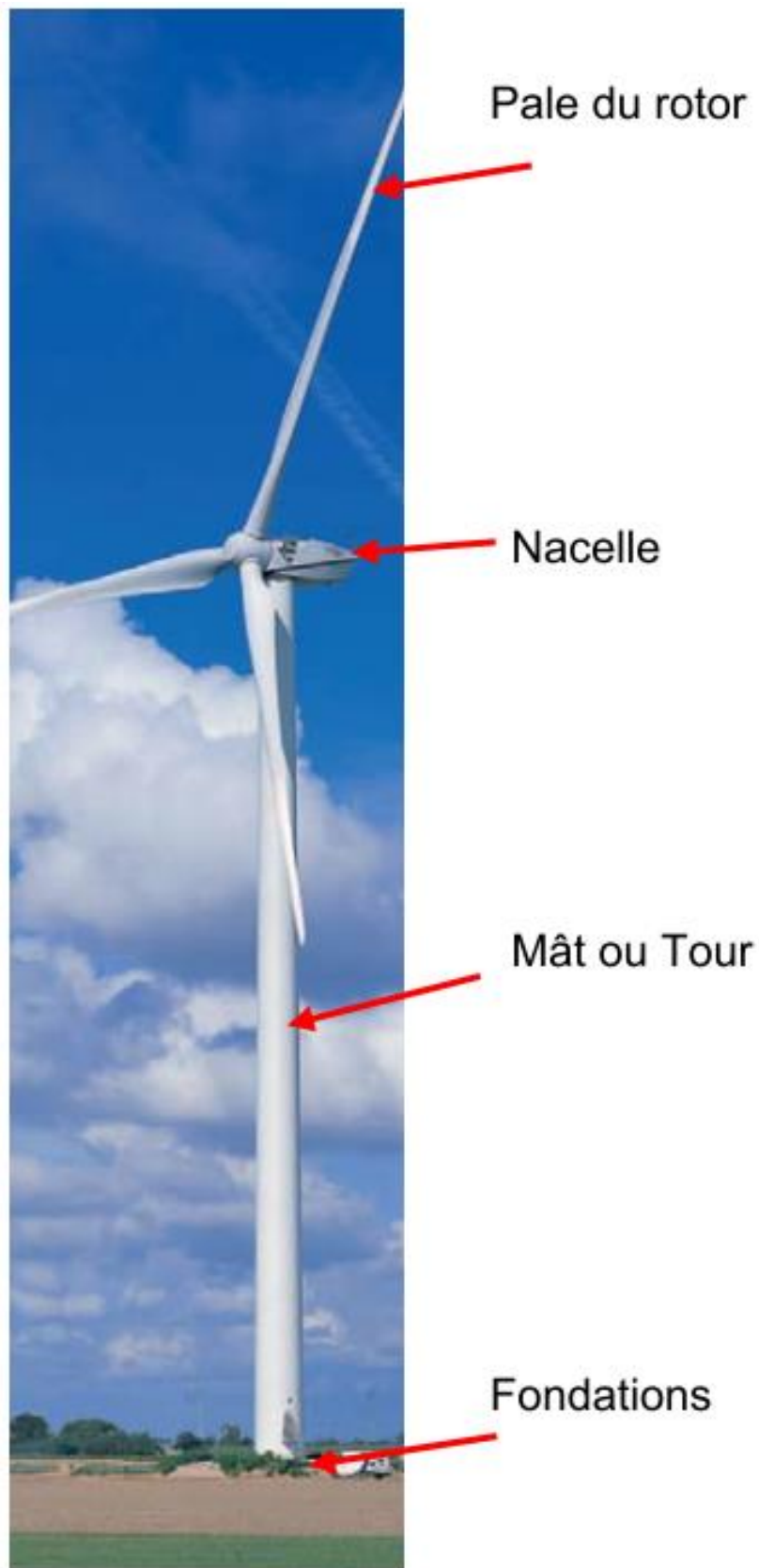
FIGURE 6 : DESCRIPTION D'UNE EOLIENNE
