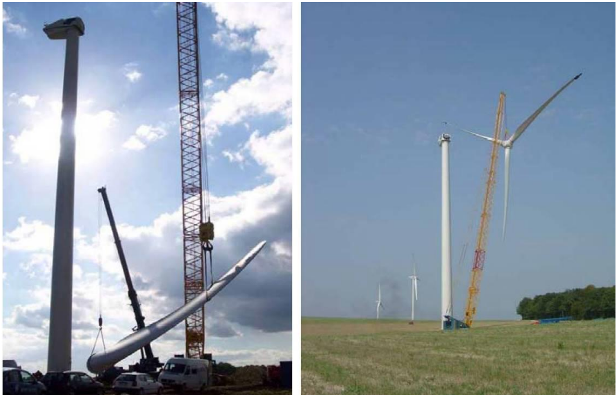
FIGURE 23 : GRUE DE MONTAGE ET ELEVAGE DU ROTOR
